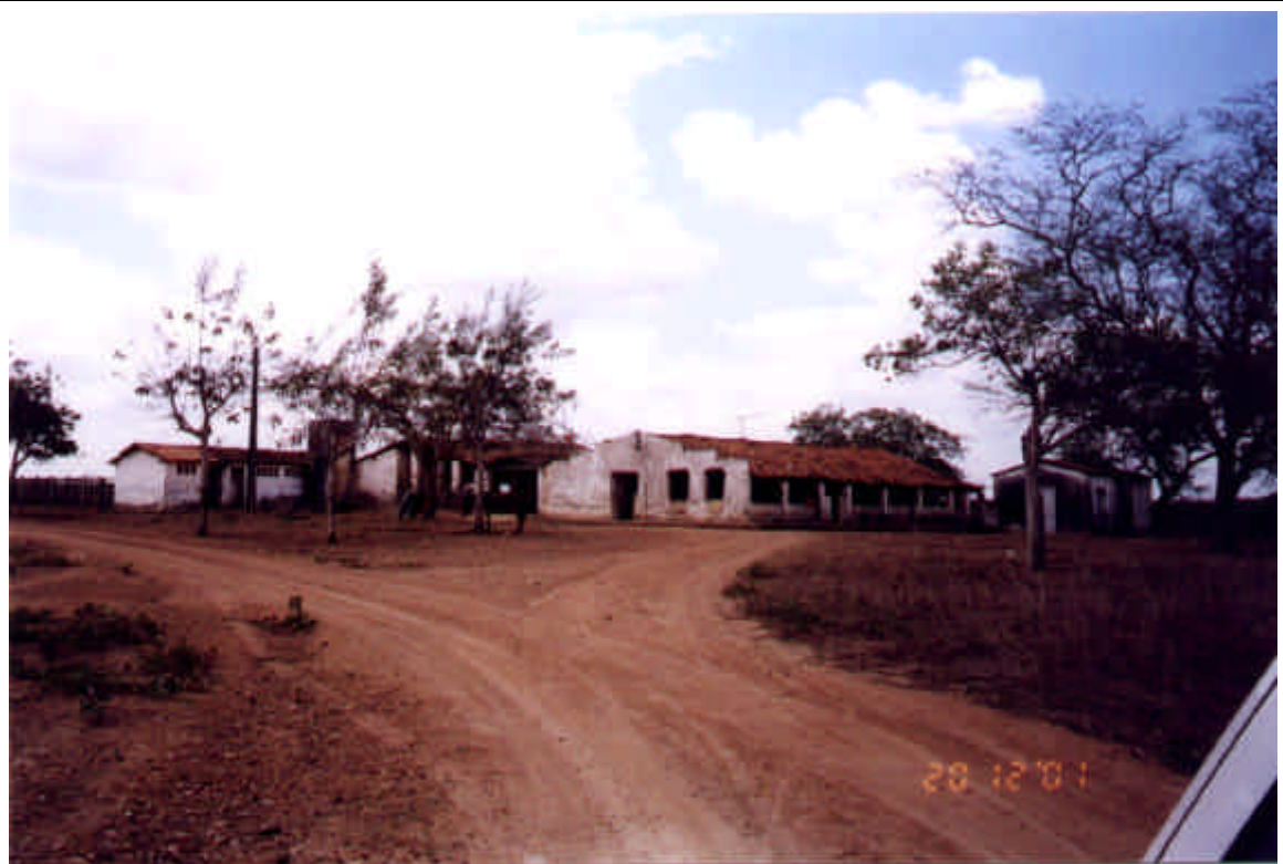
FOTO 15 – ALGUMAS ESTRUTURAS RURAIS DE MÉDIO PORTE SERÃO AFETADAS PELO AÇUDE. NESTA FOTO APARECEM ALGUMAS INSTALAÇÕES DA FAZENDA MALA, SITUADA NO CENTRO DA BACIA HIDRÁULICA. AQUI, ALÉM DA CASA APARECEM O GALPÃO DE DEPÓSITO, O ESTÁBULO E O PÁTIO PRINCIPAL DA FAZENDA.
