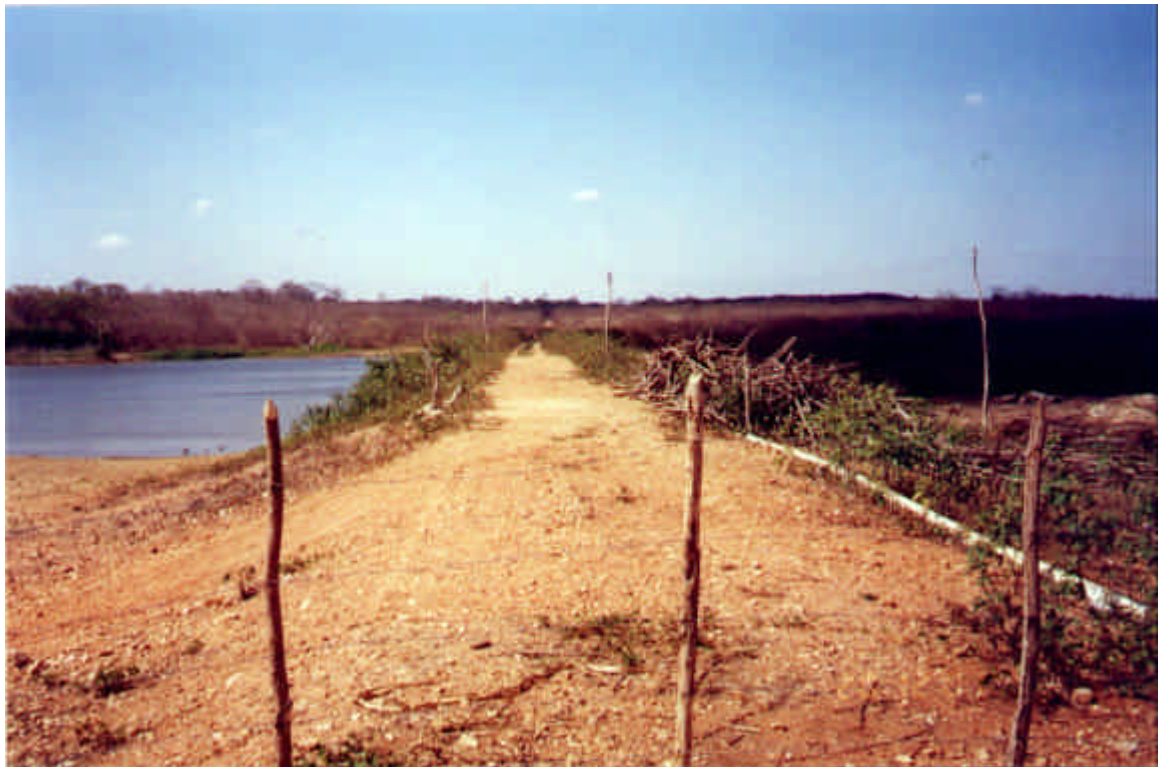
FOTO 06 – UMA DAS DRENAGENS CONTRIBUINTES À BACIA HIDRÁULICA DO AÇUDE PÚBLICO GAMELEIRA SERÁ O CANAL DE ESCOAMENTO DA BARRAGEM DO CIPÓ (SETOR OESTE). ESTA BARRAGEM É A MAIOR ENCONTRADA NA ÁREA TENDO O SEU EIXO CERCA DE 250 m.
