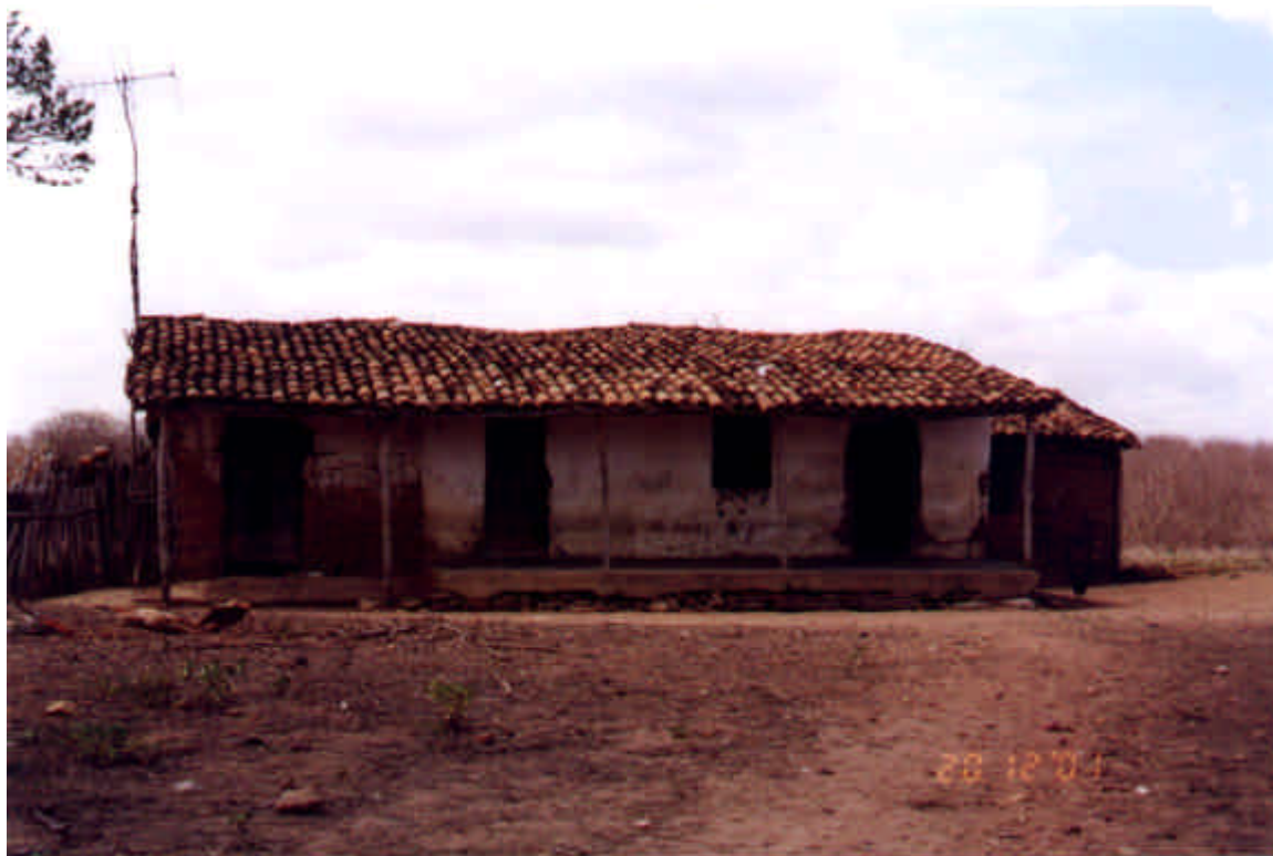
FOTO 13 – EM GERAL, AS FAMÍLIAS QUE SERÃO ATINGIDAS NA BACIA HIDRÁULICA DO AÇUDE SÃO DE MORADORES QUE OCUPAM PEQUENAS CASAS DE TAIPA. A FOTO APRESENTA UM EXEMPLO DESTAS MORADIAS SITUADAS NO LADO PERTENCENTE AO MUNICÍPIO DE TRAIRI.
